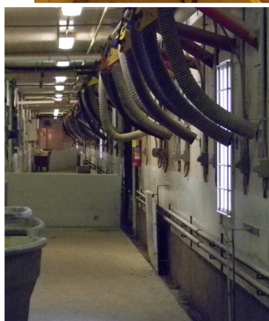
Bâtiments porcins. Photos : Prairie Swine Centre
